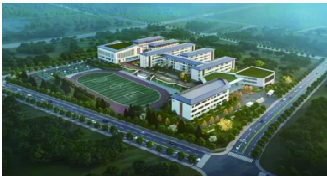
建设中的航埠新城初级中学项目(航埠新城K12学校)效果图
